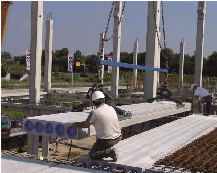
Die Produktion in unserem Werk erfolgt durch den Einsatz von Extruderfertigern und Gleitfertigern. Damit können wir diverse unterschiedliche Querschnitte herstellen. Ebenfalls sind auch vorgespannte Vollbetondecken herstellbar. Nach dem Verguss der Plattenfugen und der Herstellung des umlaufenden Ringankers kann man mit den weiteren Arbeiten auf der Decke fortfahren. Ebenfalls ist ein behinderungsfreies Arbeiten im Geschoss darunter durch die unterstützungsfreie
