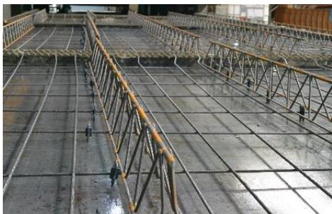
**Die BWH-Elementdecke wird standardmäßig in einer Dicke von 5cm gefertigt. Die Gitterträger dienen der Aufnahme der Schubkräfte und sorgen für die Steifigkeit beim Verlegen der Decke. Werkseitig können Einbauteile für die Elektroinstallation oder auch für die Betonkern-aktivierung (heizen und kühlen) eingebaut werden.**
